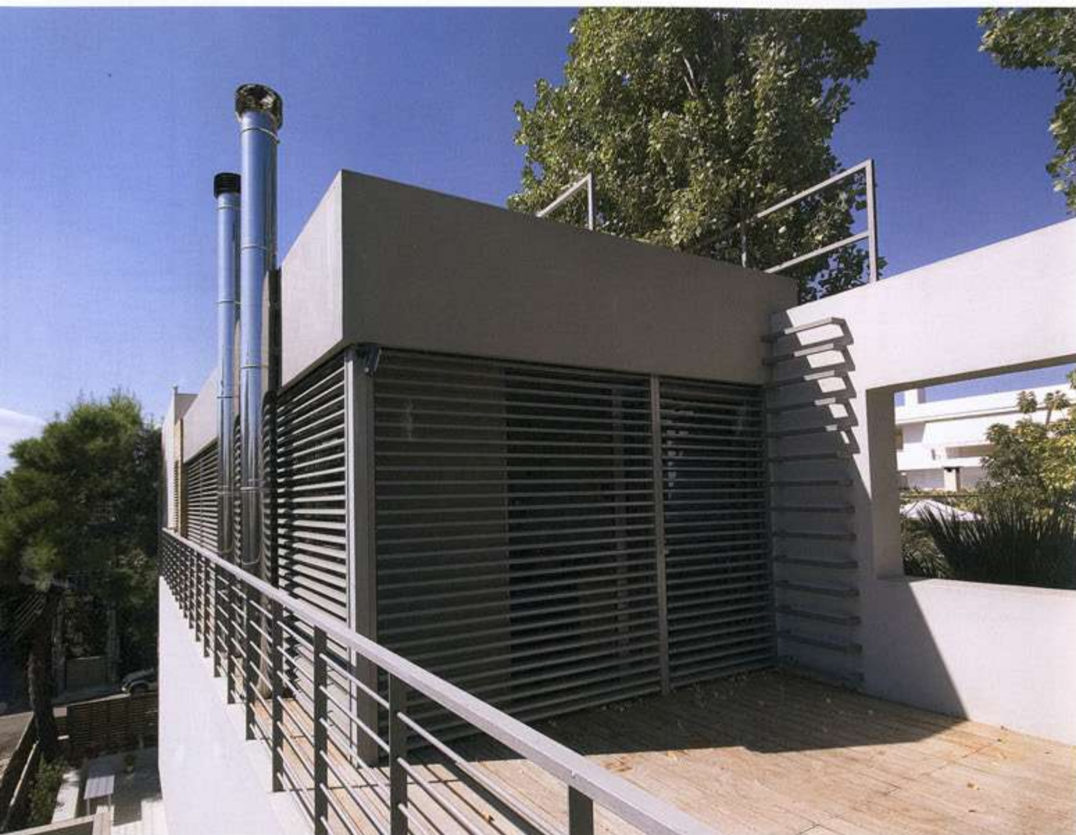
Στο β' όροφο τοποθετήθηκαν μεταλλικές περσίδες με τη λογική του "φίλτρου", ώστε να ελέγχεται η οπτική επαφή, η ιδιωτικότητα και ο φωτισμός.
