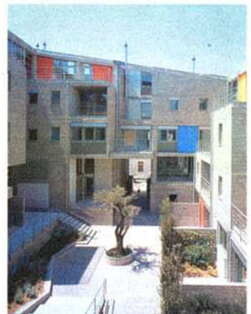
Στην πολυκατοικία της οδού Μυλλέρου στο Μεταξουργείο δημιουργούνται κενά στον συμπαγή όγκο της για να φυτευθεί πράσινο σε δώματα και σε εσοχές της κτιριακής μάζας, αλλά και για να διαμορφωθεί ένα κεντρικό αίθριο με χαρακτηριστικά αυλής, σύμφωνα με την πρόταση των αρχιτεκτόνων Γεωργίας Δασκαλάκη και Γιάννη Παπαδόπουλου
