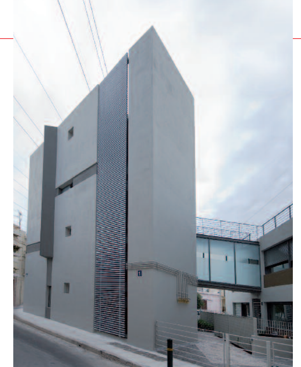
ΤΕΤΡΑΩΡΟΦΟ ΚΤΙΡΙΟ ΦΟΙΤΗΤΙΚΩΝ STUDIOΣ ΣΤΟ ΑΙΓΑΛΕΩ, 2007, © ΚΩΣΤΑΣ ΔΡΙΜΤΖΙΑΣ.
